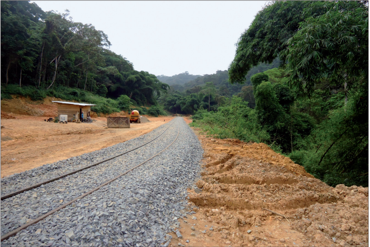
REPUBBLICA DEL CONGO, SEAS, costruzione rete ferroviaria
