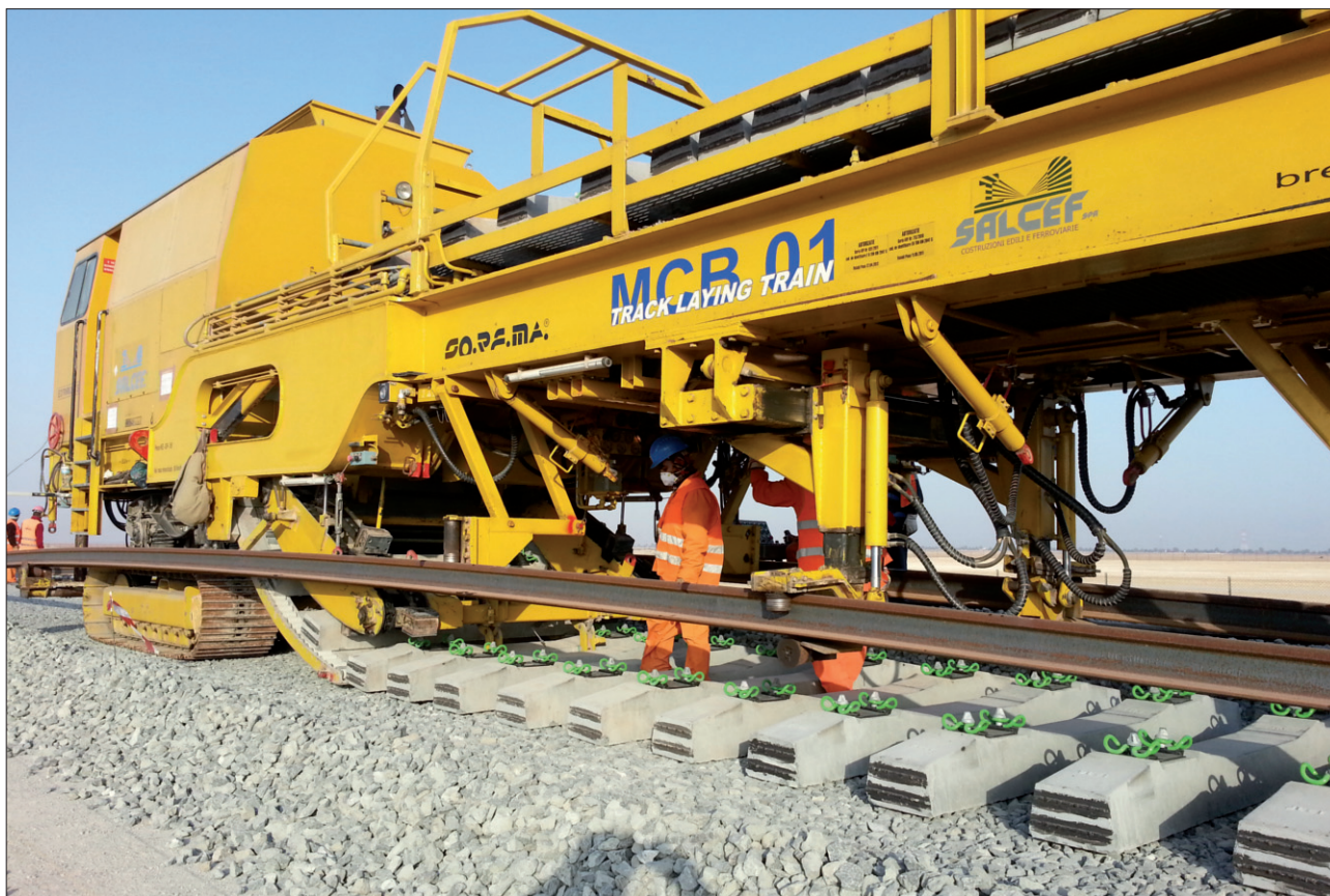
POLONIA, Salcef, costruzione binario
