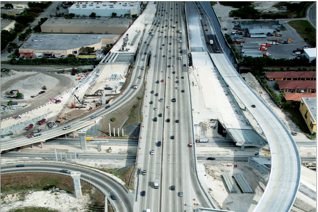
USA, Condotte, Svincolo autostradale
