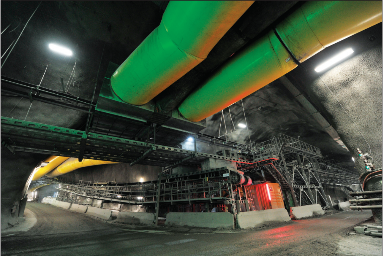
SVIZZERA, Condotte, Galleria di base del Ceneri
